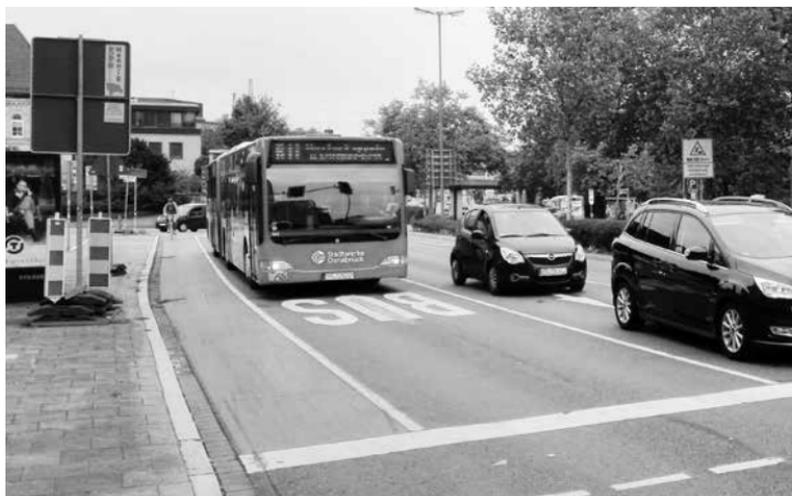
Auf dem Foto sieht man eine Sonderspur. Das hat nur etwas Farbe gekostet und die Störhalte für die Busse um fast 50 Prozent reduziert. Die kürzeren Buswartezeiten sparen rund 30.000 Euro pro Jahr.
