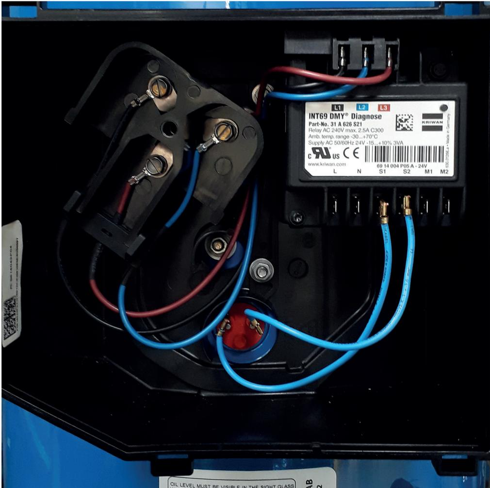
**Abb. 2.8** Verdichterschutz mit integrierter Phasenüberwachung (Abb. Danfoss)
